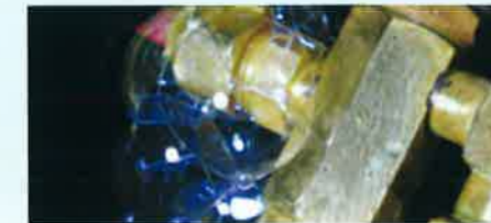
発泡液で漏えいを確認
