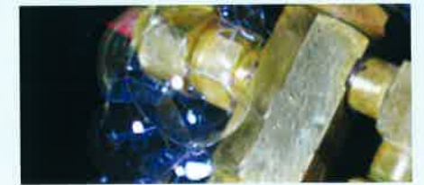
発泡液で漏えいを確認
